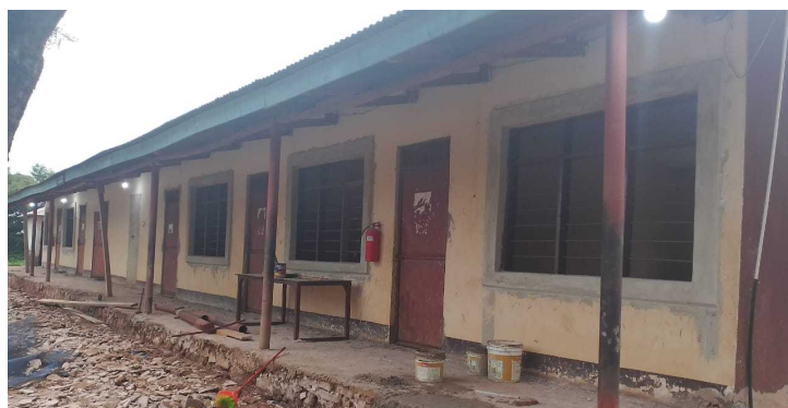
Das entkernte alte Schlafgebäude
