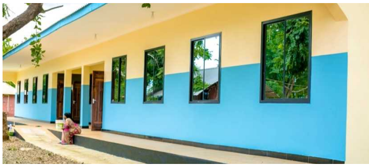
Das neuere Schlafgebäude nach der Renovierung
